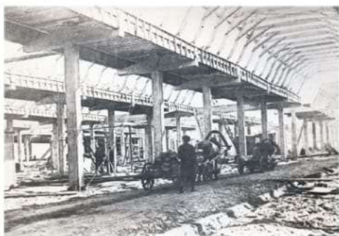
Строительство главного корпуса. 1938 г.
